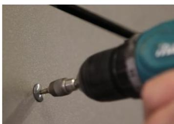
Partendo dai fori centrali e lavorando verso l'esterno fino ai bordi del pannello, posizionare le viti UNI Screw al centro del foro preforato. Impostare la funzione serraggio (frizione) per evitare di stringere troppo le viti.
