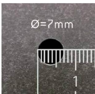
Il pannello deve essere preforato con un foro di 7 mm di diametro. Utilizzare la punta per fibrocemento EQUITONE. Contrassegnare accuratamente le posizioni dei fori sulla faccia frontale del pannello. Si prega di notare che è preferibile utilizzare una matita colorata per marcare un pannello grigio, poiché un segno di matita grigio può causare confusione. Forare un pannello alla volta con la faccia rivolta verso l'alto.
