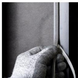
Posizionare il nastro di guarnizione sui profili verticali. Assicurarsi che il nastro sia continuo. Su ogni profilo a "T" posizionare il nastro su ogni lato dietro i 2 pannelli.
