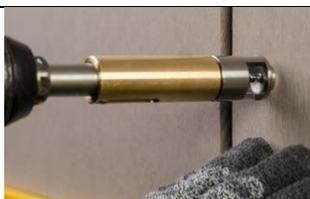
Partendo dai punti fissi (**STOP**), inserire il centratore EQUITONE da 4,1 mm nei fori e forare i profili della sottostruttura. Rimuovere eventuali residui.
